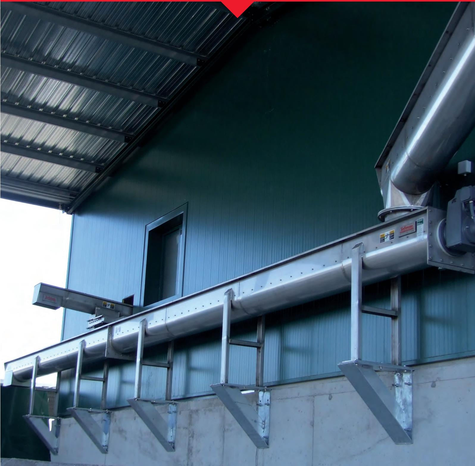
Para el transporte, elevación, compactado, desarenado de lodos y similares.
