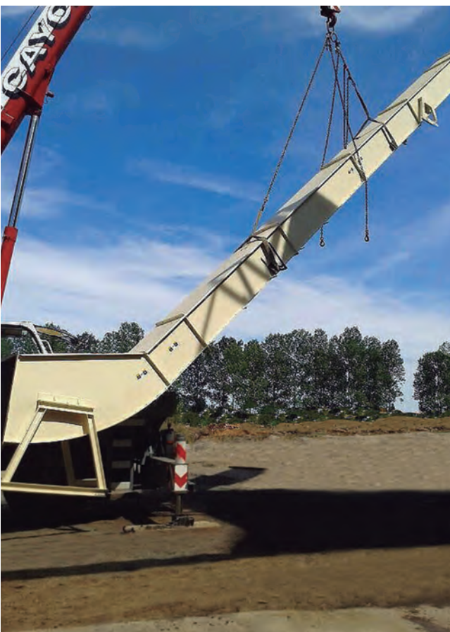
MONTAJE REDLER INCLINADO
