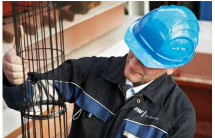
Instalación y reemplazo de mangas/cartuchos: desde la planificación del proyecto hasta la puesta en marcha, con prueba de fugas UV y precapa.
