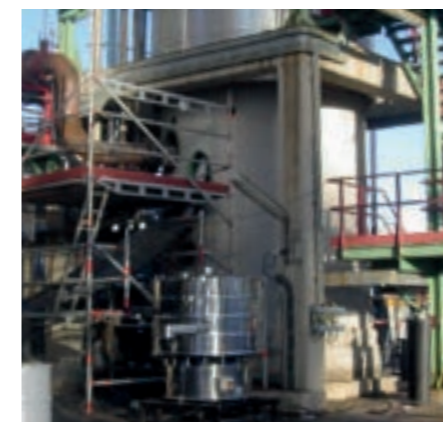
Tamizadora para separación granulométrica en planta química instalada en exterior para recuperación de materia prima. Tamizadora FTI-1500 con cuatro separaciones simultáneas.
