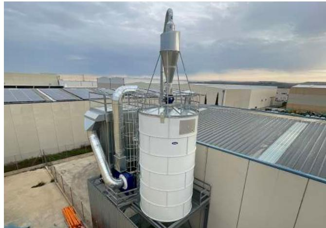
Permiten una separación eficiente del contaminante y su almacenamiento seguro, reduciendo operaciones de mantenimiento y optimizando el proceso productivo.
